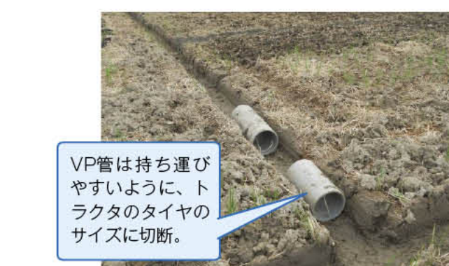
写真⑤: 明渠を崩さない工夫
