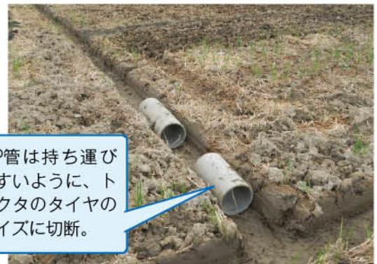
写真⑤: 明渠を崩さない工夫
