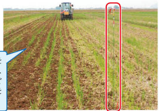
写真④: まっすぐな明渠の設置
